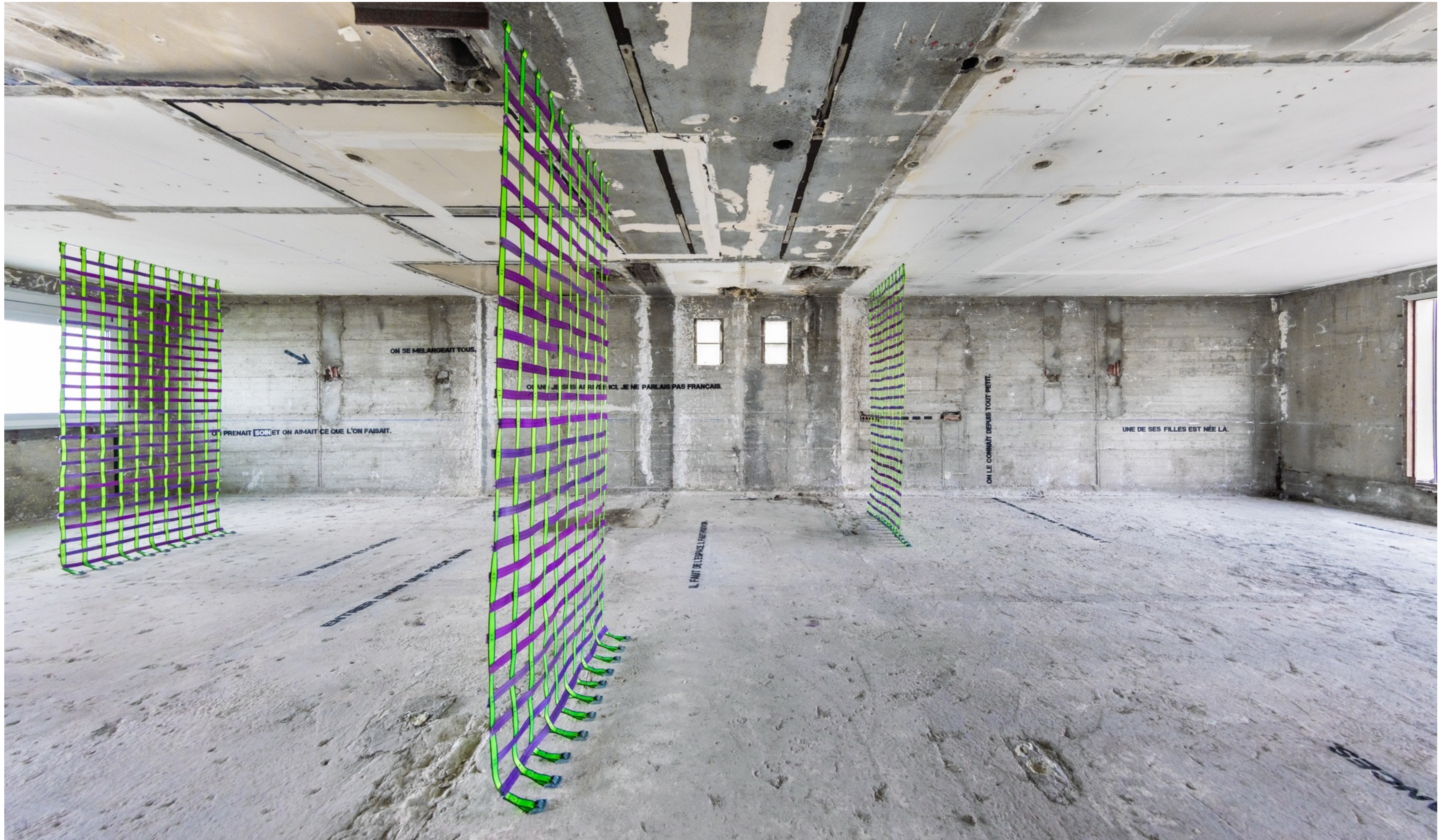
Vue d'exposition, clinique en travaux Paris 13ème
